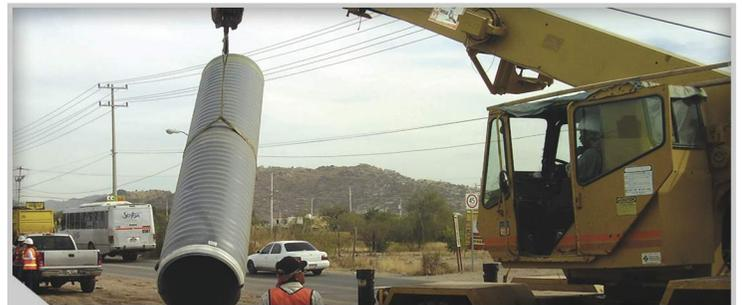
La tubería tiene la sección transversal completamente circular, con corrugaciones interiores anulares, así como paredes interior y exterior lisas, cumpliendo satisfactoriamente con la norma la norma ASTM F2764-11.
